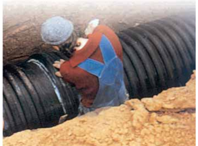
FKS boruların contalı birleşim kesiti.
