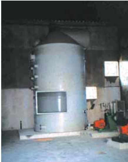
PP'den üretilmiş tank örneği
