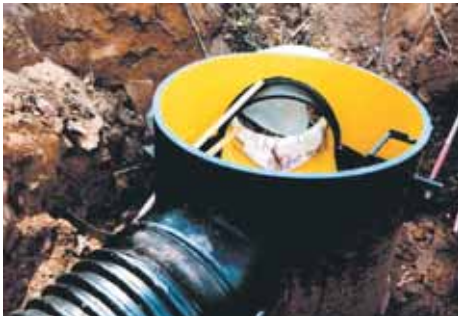
Dönüş noktasında giriş çıkışlı menhol, boru içi ark ve merdiven uygulamalı.
